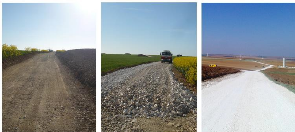
Décapage ; Couche de fond de forme ; Couche de finition Photos de gauche à droite (Source : RES – Parc éolien de Forterre)
